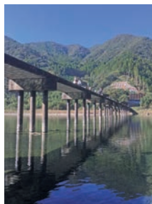
欄干のない沈下橋
